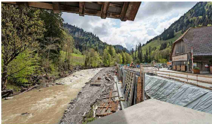
Ein breiteres Flussbett, eine Stützmauer und dahinter ein Damm sollen dafür sorgen, dass der Hotelbetrieb nie mehr überflutet wird.
